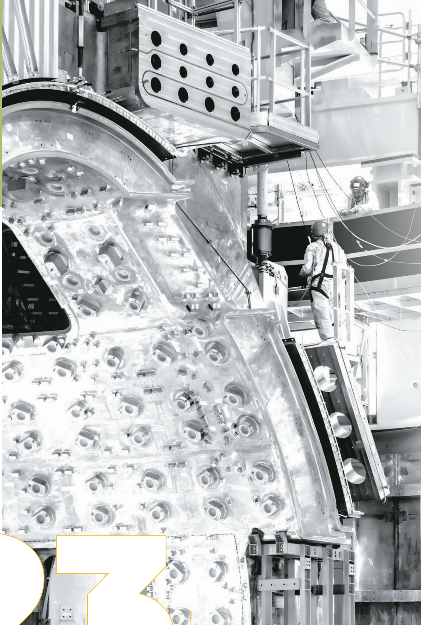
Fin juin, des techniciens s'affairaient autour du secteur de la chambre à vide qui doit être retiré de la fosse.
