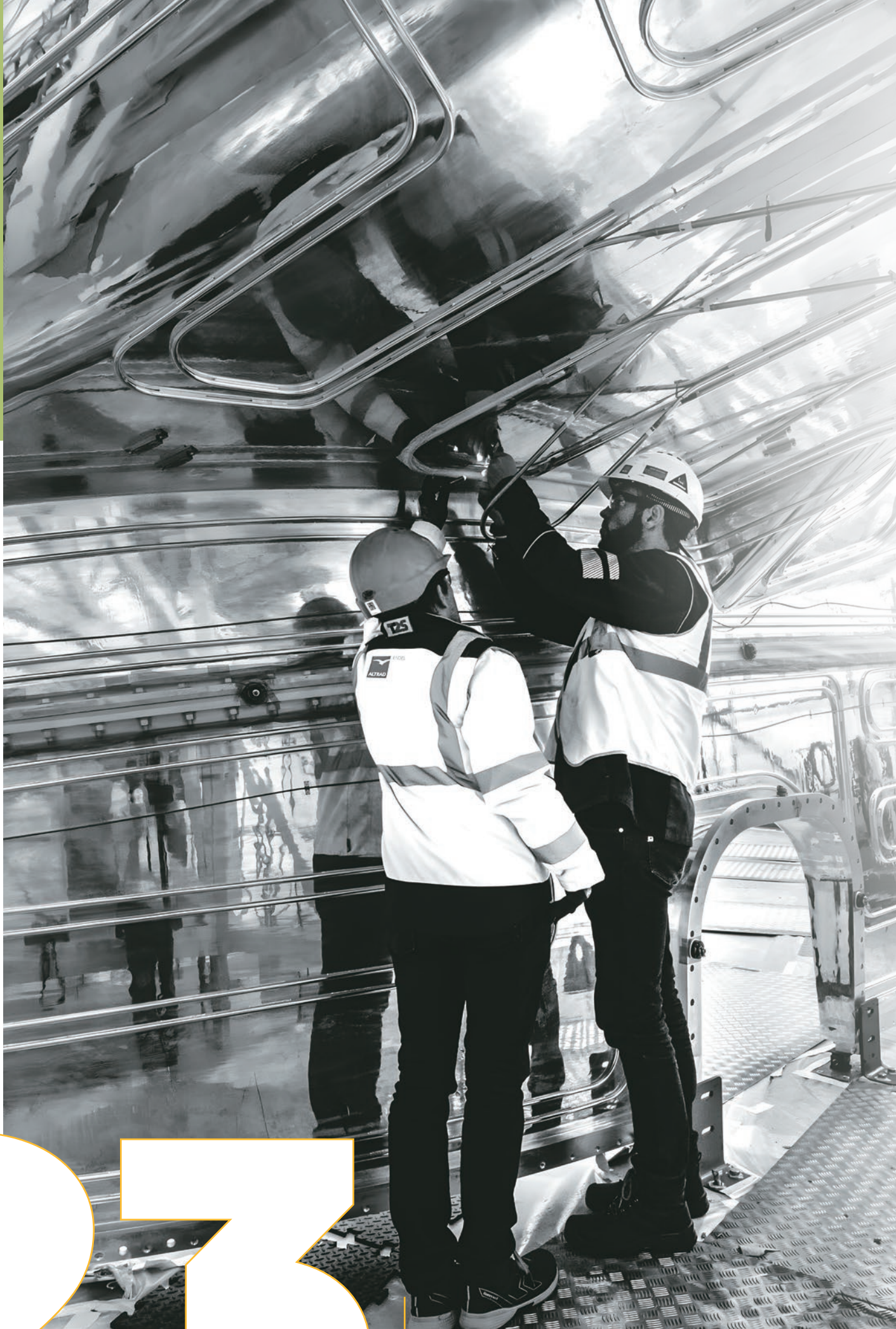
Ces derniers mois ont été consacrés aux analyses et aux discussions d'experts. La solution retenue pour les panneaux d'écran thermique ? Retirer et remplacer les tubulures du circuit de refroidissement de l'écran thermique (23 km au total).
